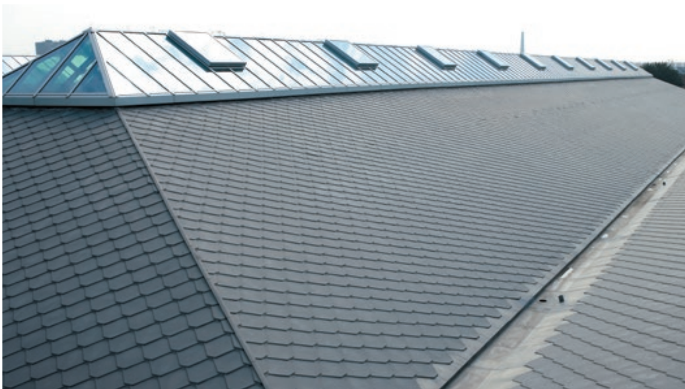
Entrepôt, Gent (Belgique) - Architecte : BERTELOOT Ro - Entreprise : STOCKMAN Dakwerken - Photographie : what if ...
